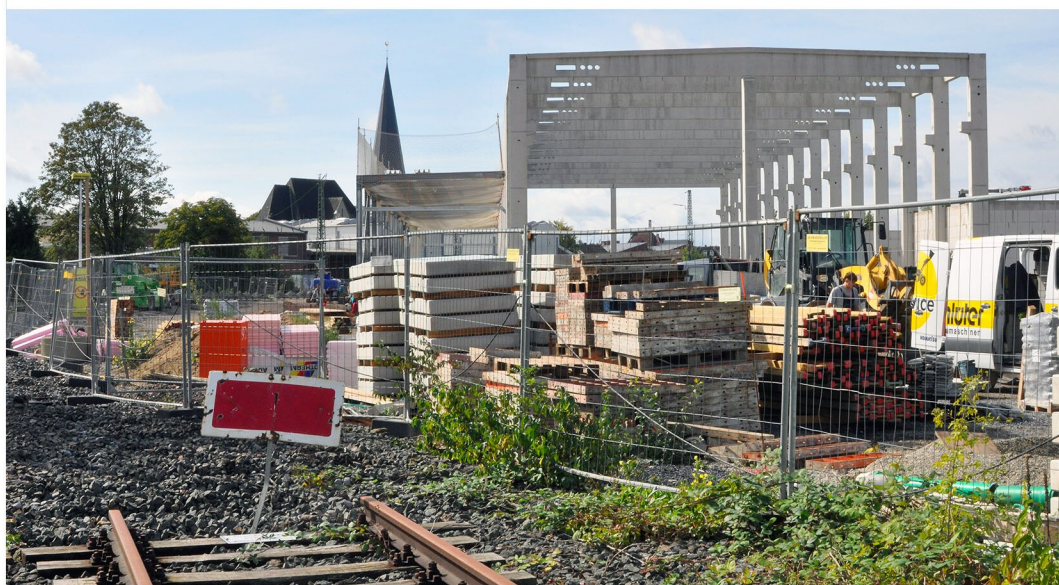
Die Baustelle des CAF-Betriebswerkes in Neubeckum. (Foto: Werner Szybalski)
